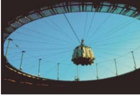
AdK_Schlaich-Berg_Saragossa 1 Wandelbares Dach der Stierkampfarena, Saragossa, Spanien, 1990 © Foto: Schlaich, Bergemann und Partner, Stuttgart
