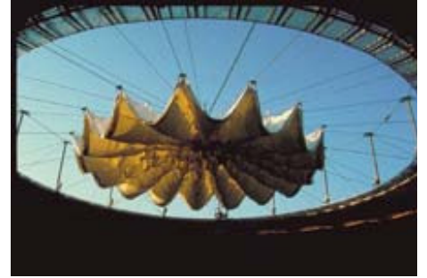
AdK_Schlaich-Berg_Saragossa 3 Wandelbares Dach der Stierkampfarena, Saragossa, Spanien, 1990 © Foto: Schlaich, Bergemann und Partner, Stuttgart
