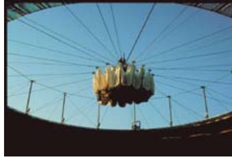
AdK_Schlaich-Berg_Saragossa 2 Wandelbares Dach der Stierkampfarena, Saragossa, Spanien, 1990 © Foto: Schlaich, Bergemann und Partner, Stuttgart
