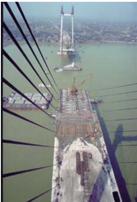
AdK_Schlaich-Berg_Brücke 1 Hooghly Brücke, Kolkata, Indien, im Bau, 1978–1992 © Foto: Schlaich, Bergemann und Partner, Stuttgart
