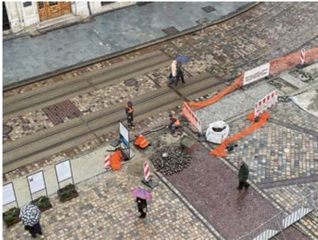
Um die historische Innenstadt von Lwiw barriereärmer zu gestalten, wurde das vorhandene Kopfsteinpflaster abgeflacht und an gleicher Stelle wieder eingesetzt. | To make Lviv's historic city centre more accessible, the existing cobblestones were taken up, smoothed and put back in the same place.
